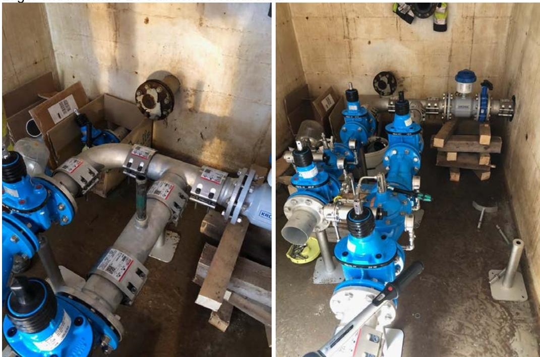
Verrohrung Pumpenschacht DN100 mit Edelstahl-Formteilen und Straub-Grip-Rohrkupplungen
