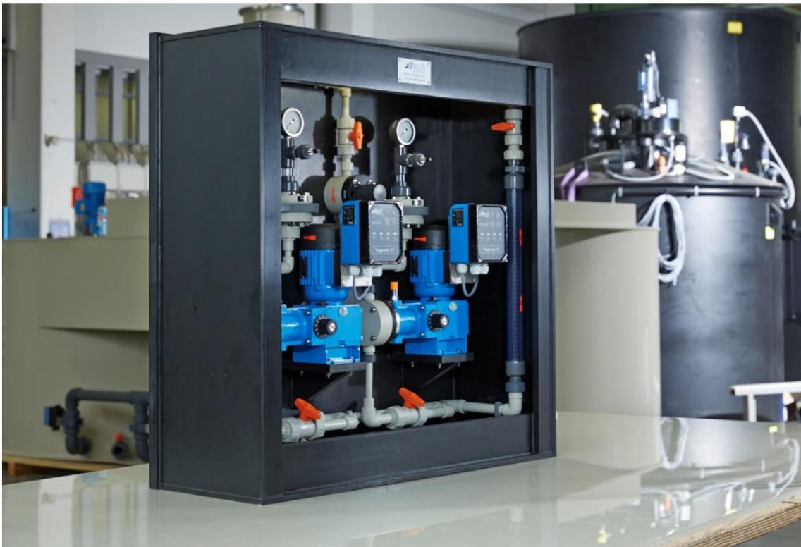
*Bild: Beispiel für ein Eisen-III-Chlorid Dosiersystem*
