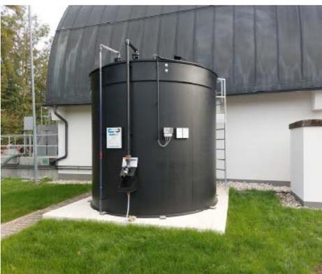
Abschließend waren nur noch die Strom- und Steuerleitungen sowie die beiden Dosierleitungen zu den Zuläufen der Belebungsbecken zu verlegen.
