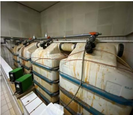
Das dazu verwendete Eisendreichlorid wurde in vier großen Kunststoffheizölbehältern mit je 5.000 Liter Fassungsvermögen gelagert.
