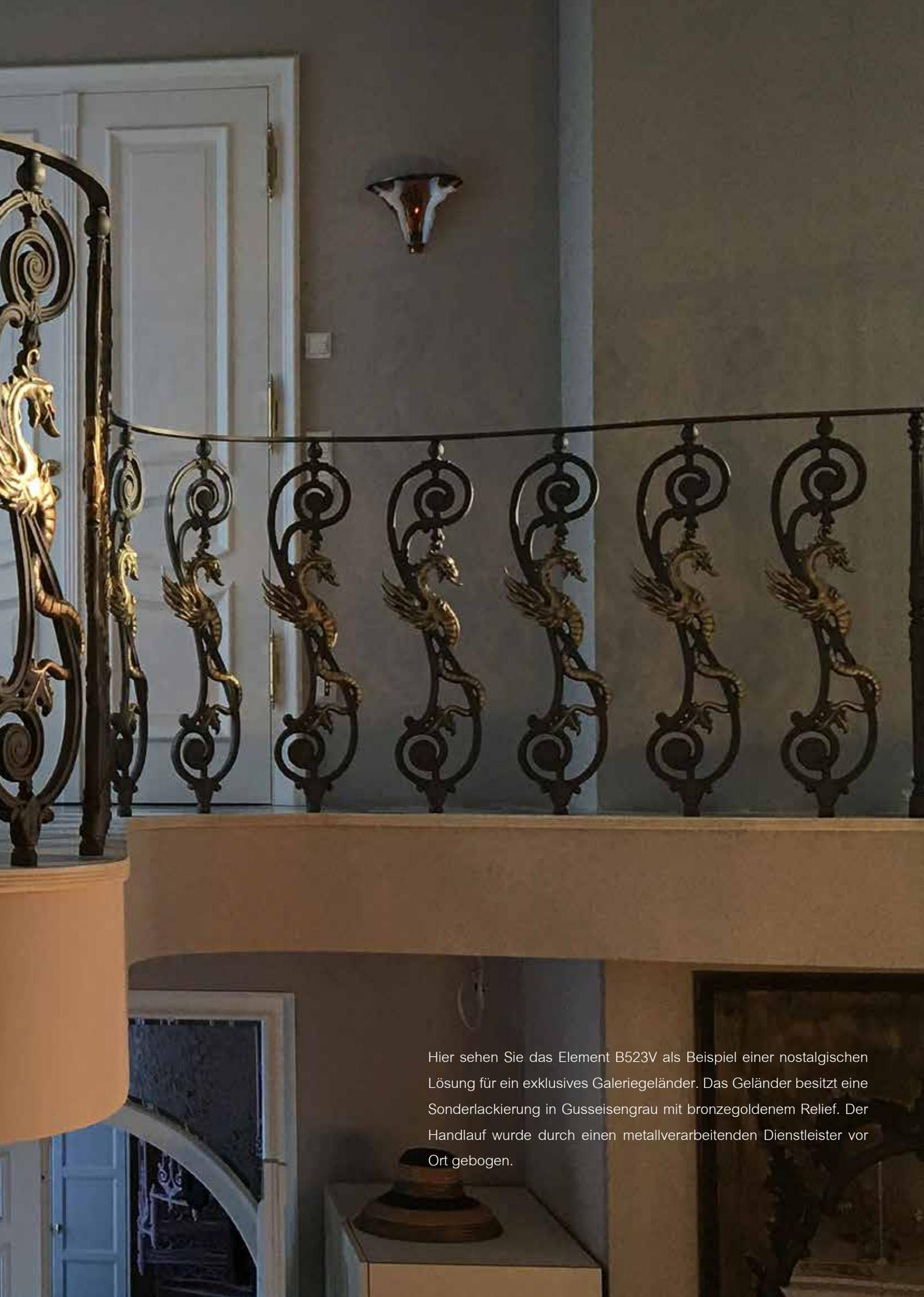
Hier sehen Sie das Element B523V als Beispiel einer nostalgischen Lösung für ein exklusives Galeriegeländer. Das Geländer besitzt eine Sonderlackierung in Gusseisengrau mit bronzegoldenem Relief. Der Handlauf wurde durch einen metallverarbeitenden Dienstleister vor Ort gebogen.
